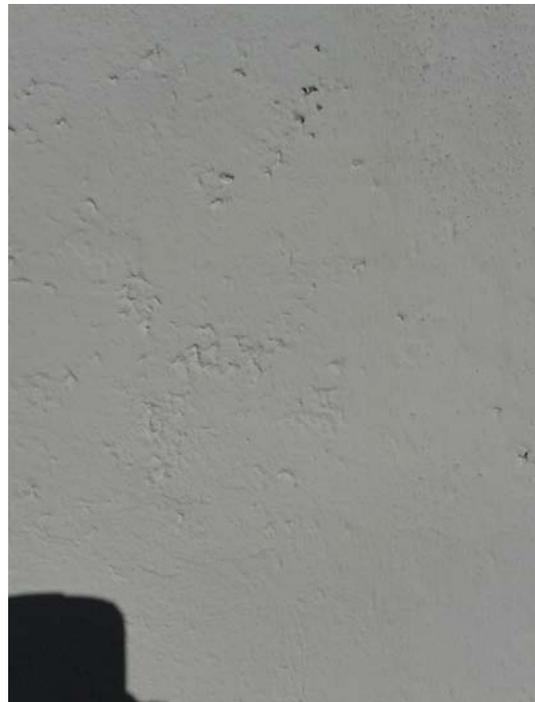
2. Mortero de cal aérea en pasta de Unicmall, o similar, dosificación 1:3 CAL GRAVA Y ARENA Y ADICIONANDO 0.2% de fibras de polipropileno, espesor EN UNA CAPA ENTRE 1-1,5 CM, aplicado sobre muro humectado previamente mediante agua-cal, tiempo de secado entre 24-48 horas dependiendo del tiempo atmosférico, Aplicado a "la llana" (talocha), alisado manual sin maestras, a buena vista. **Poro cerrado.**
